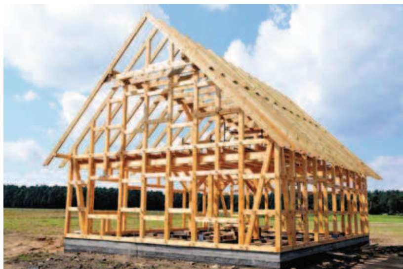
Nie sprawiło kłopotu wykonanie drewnianej konstrukcji domu typu „mur pruski”.
