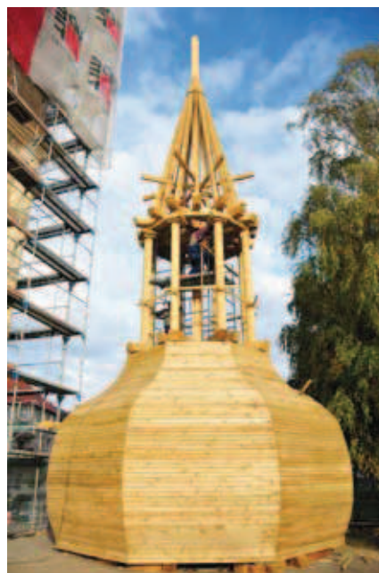
Cała konstrukcja została obita deskami o szerokości 7 cm.
